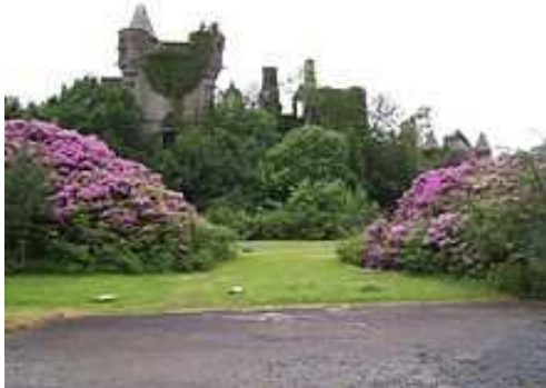
Il tetto è stato rimosso nel 1954 per non pagare le tasse
